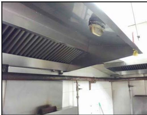
图 4.1-3 第二住院部餐厅油烟净化器及排气口
