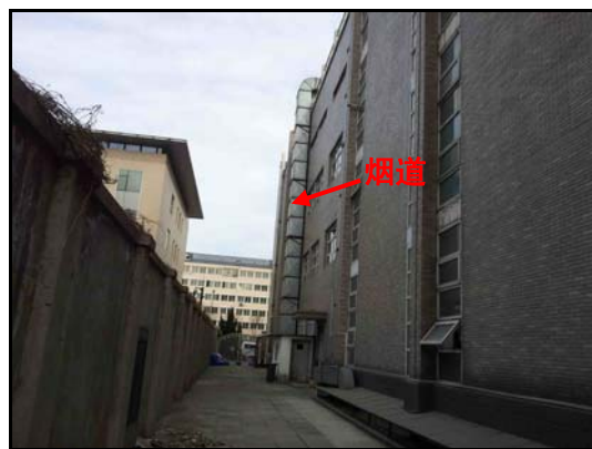
图 4.1-3 第二住院部餐厅油烟净化器及排气口
