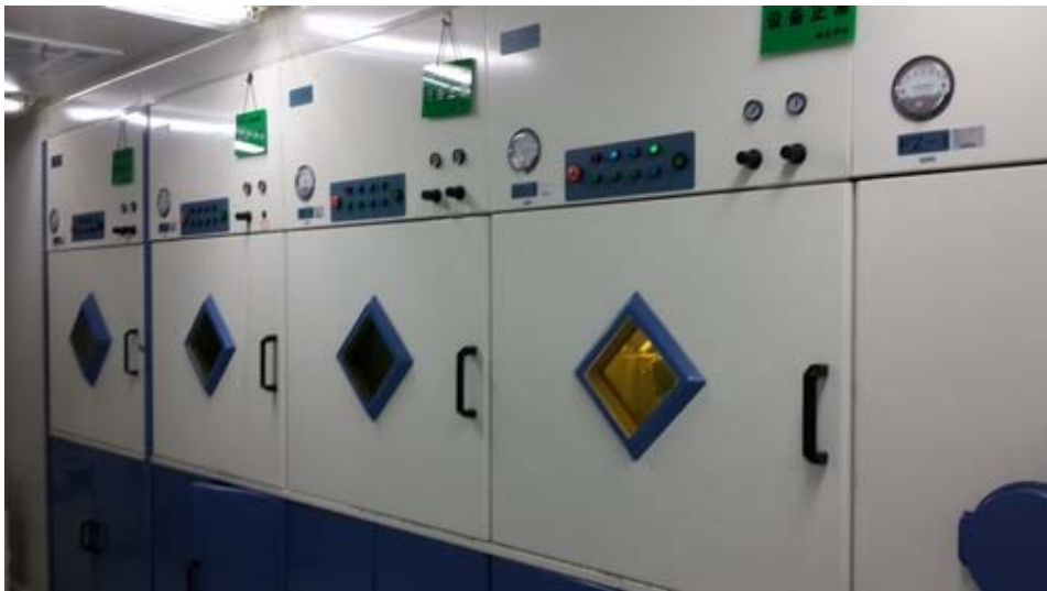
图 9-16 回旋加速器合成热室外观示意图
