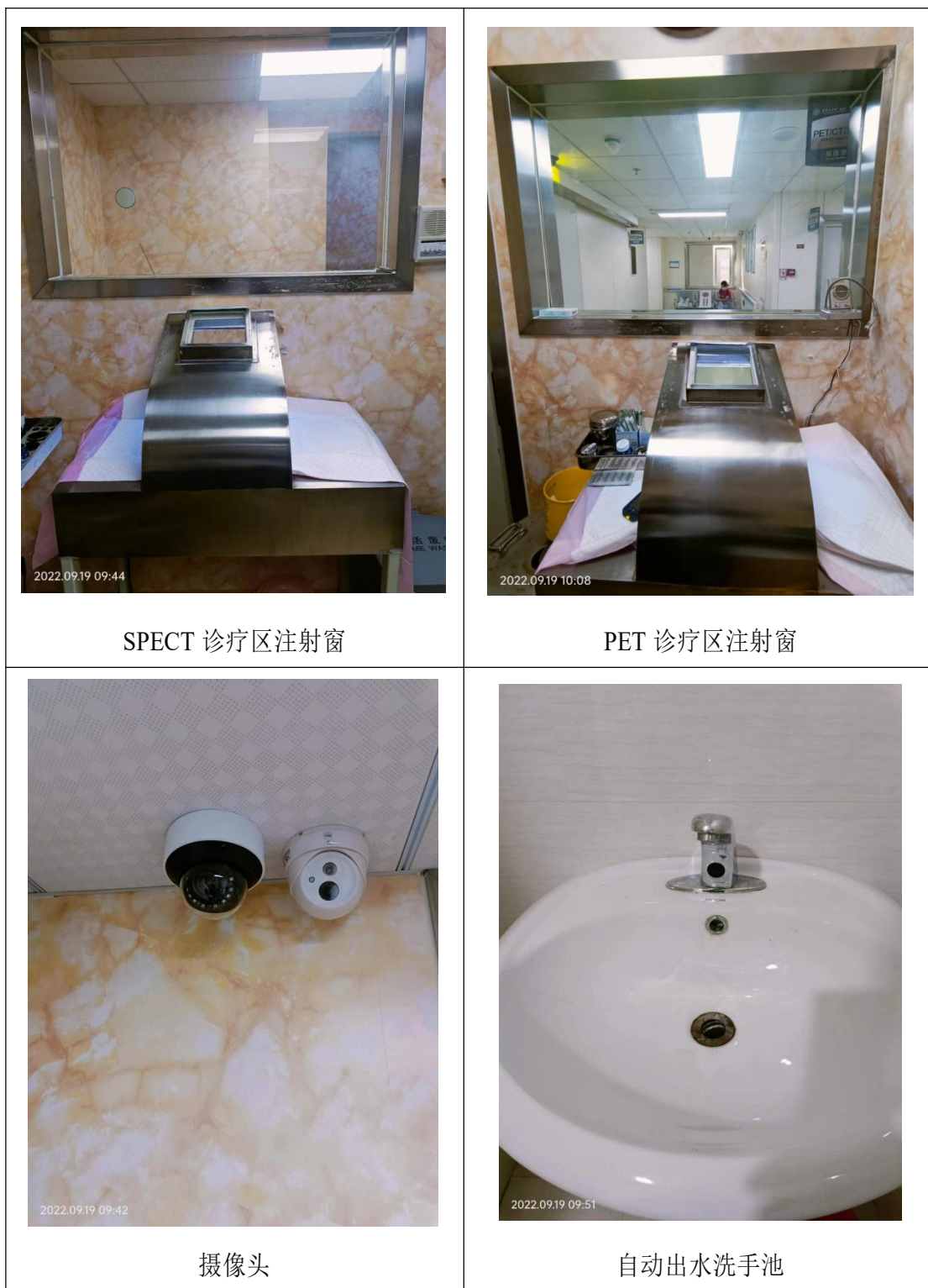
图 4-1 核医学科安全防护措施照片
