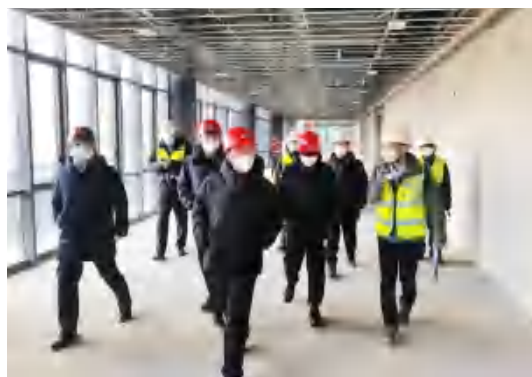
城南院区现场探勘
