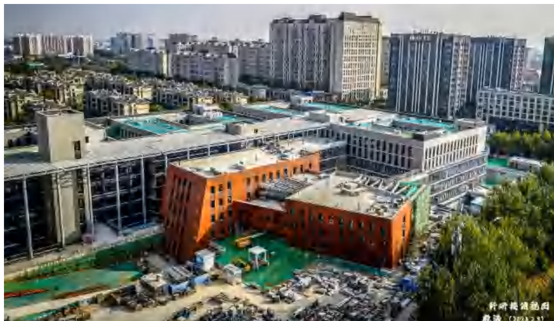
科研楼俯视图
