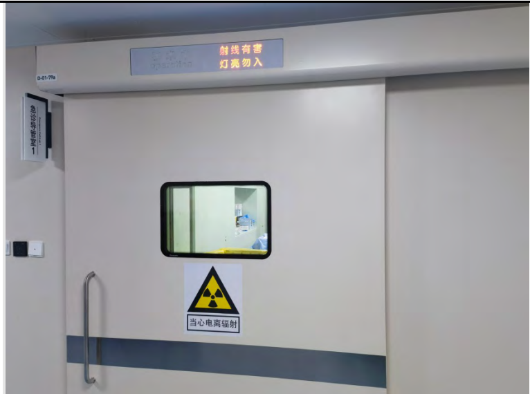
患者出入口设置的放射性标志、中文警示说明和“射线有害 灯亮勿入”警示灯
