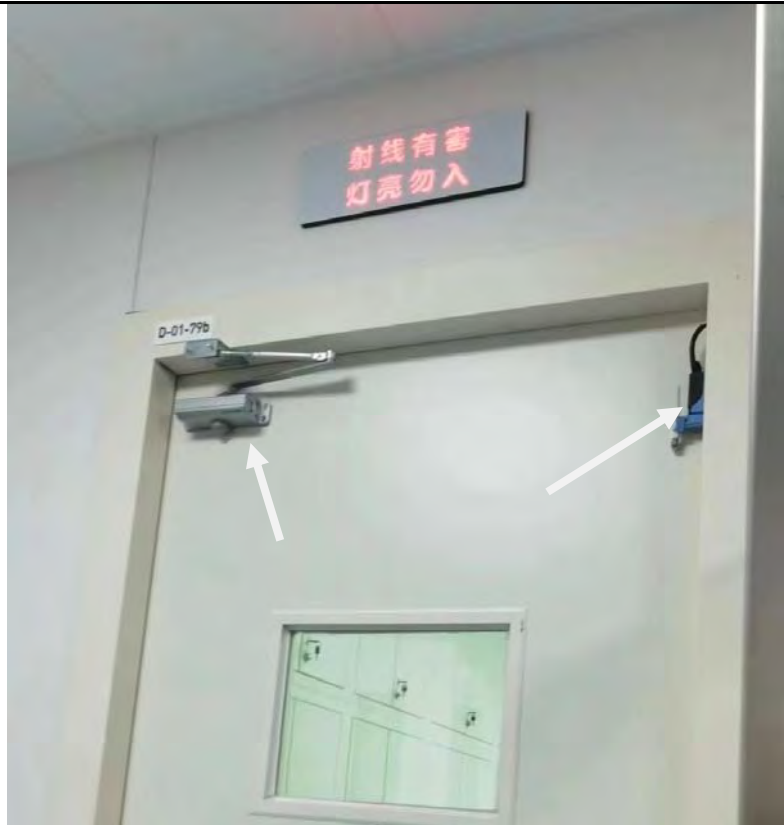
门灯联锁触点和闭门器
