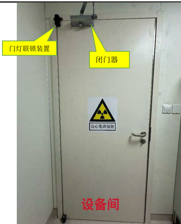
设备间防护门外设置的放射性标志、中文警示说明，门上设闭门器、门灯联锁触点
